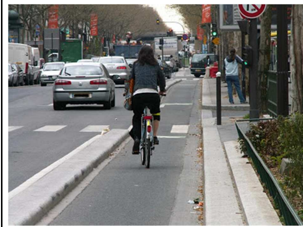
Piste sur chaussée unidirectionnelle protégée
